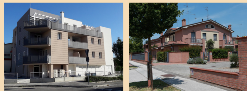
Due interventi realizzati a Budrio da Ediltecnica
